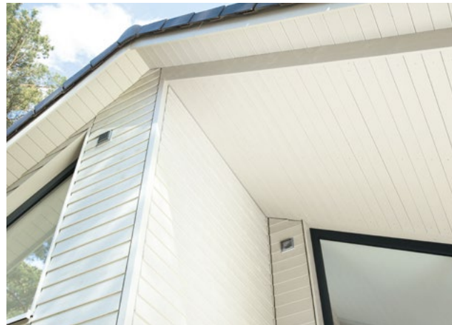
Untersichtschalung und Fassade wie aus einem Guss
