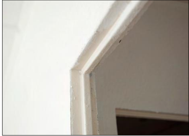
Typische Wandsituation im Plattenbau
